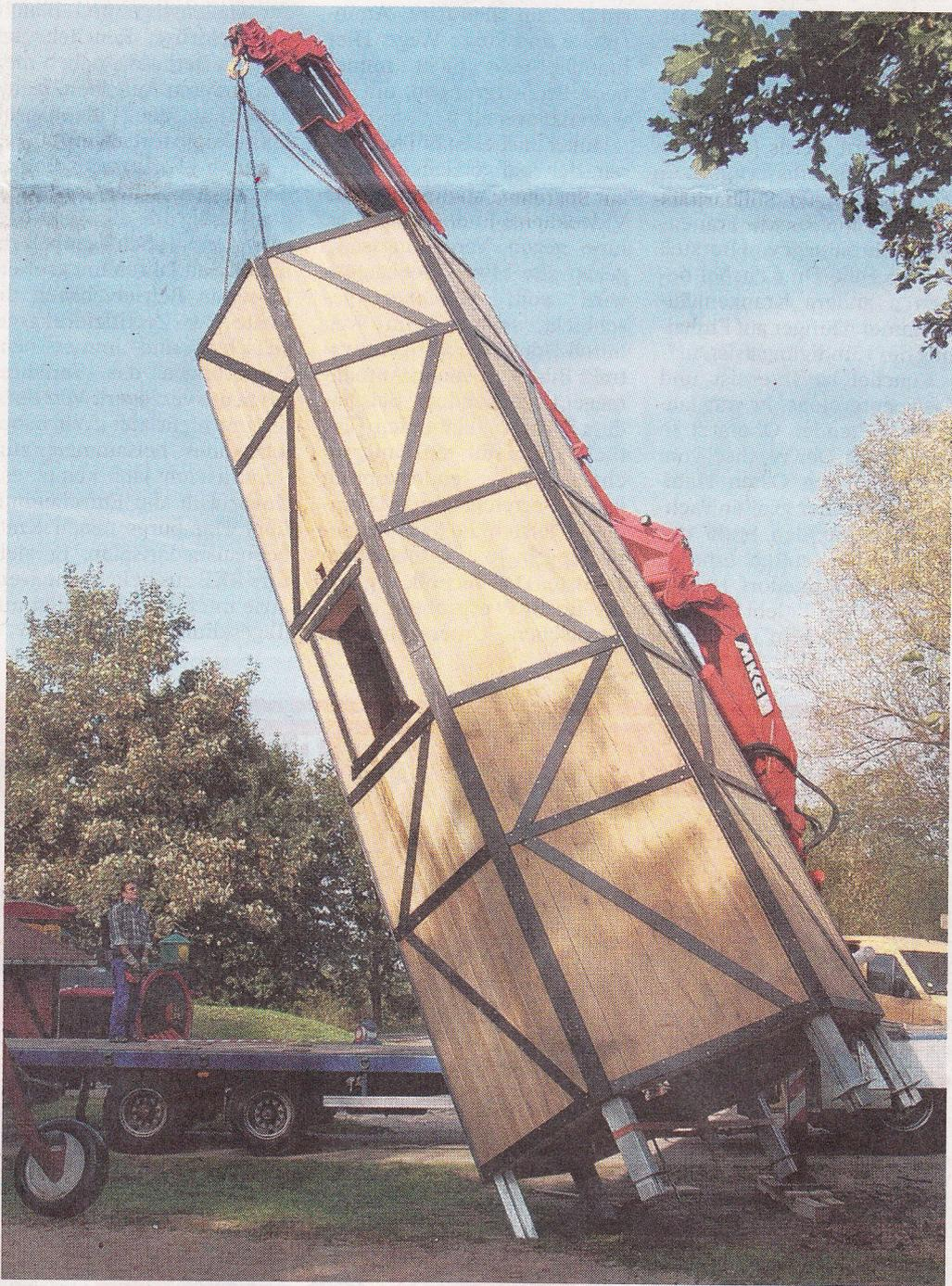
Ein Kran, der auf einem schweren Lkw befestigt ist, hievt den sechs Tonnen schweren Spiel- und Aussichtsturm auf den Boden. Das Dach-Element und die Rutsche folgen kurz darauf. Foto: Heyen
